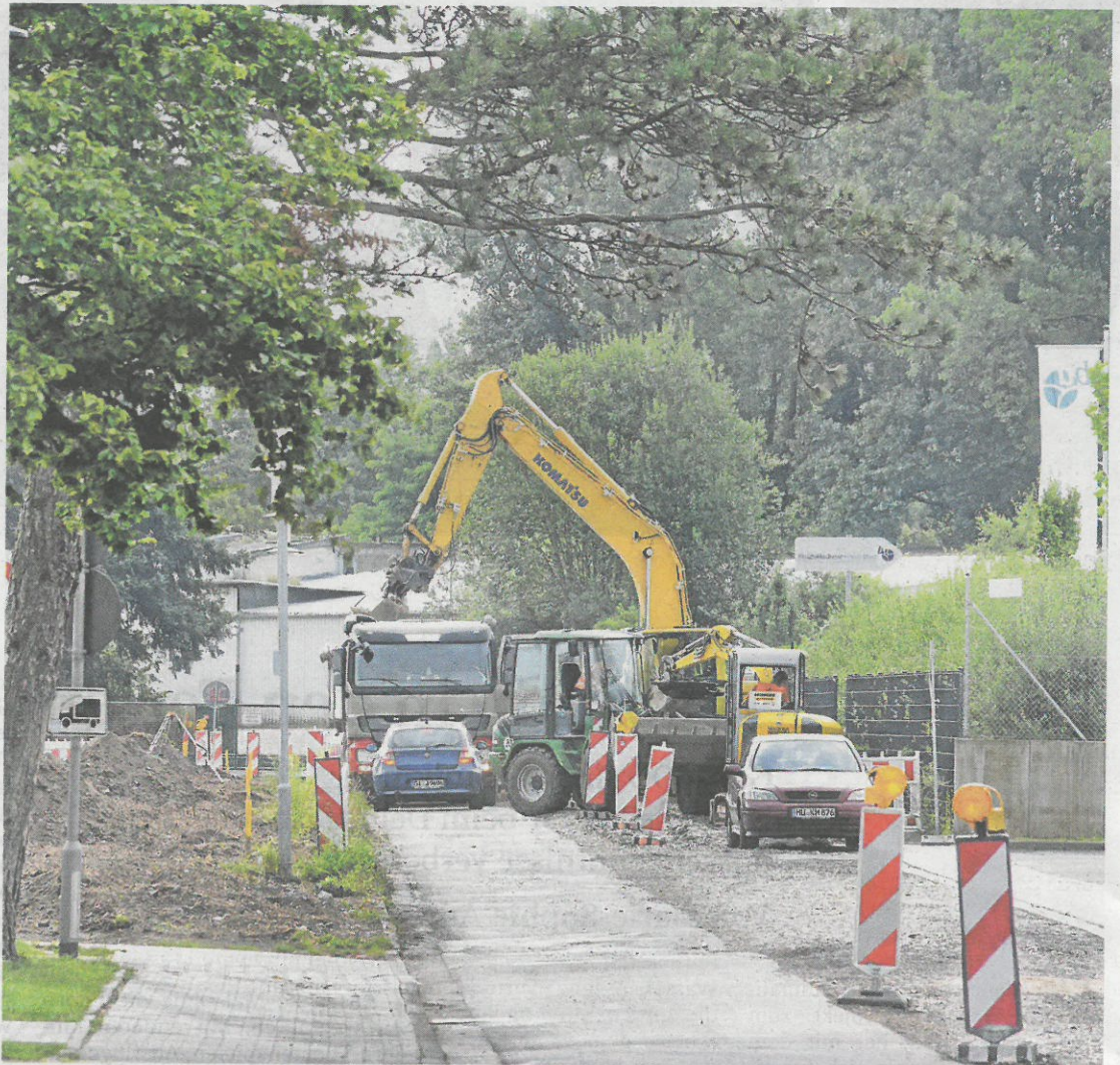
Die Straße „Am Schwimmbad“ in Urberach ist bis Jahresende eine Baustelle.
